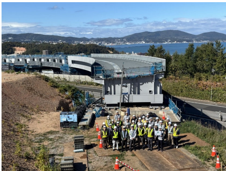
一括架設による鋼桁前での集合写真
