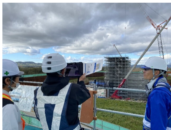
AR（拡張現実）による完成形の確認状況
