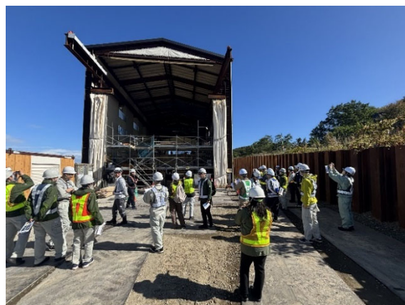
桁製作ヤードでの桁製作状況見学
