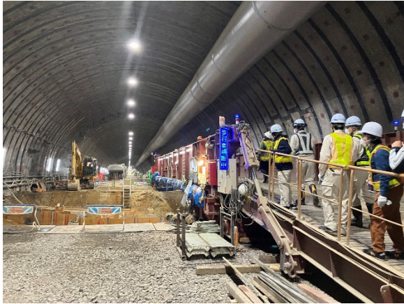
坑内見学状況（インバート工）
