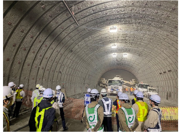
坑内見学状況（鋼製支保工建込）
