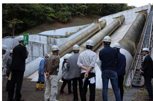
写真-14 迫力の導水管（水圧鉄管）
