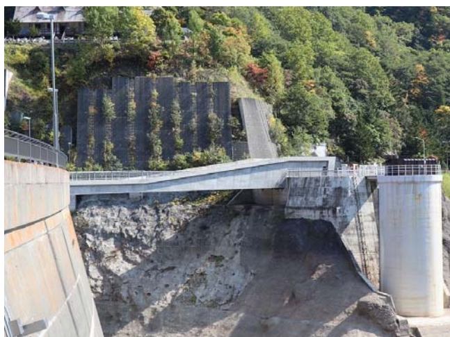
写真-3 カムイ・ニセイ橋（ゲート室から見る）
