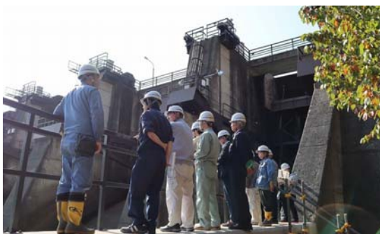
写真-9 ダム下流側から眺める砥山ダム
