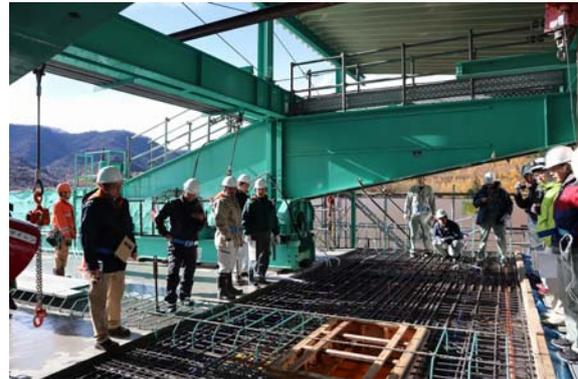
張出し先端部の移動作業車と配筋状況
