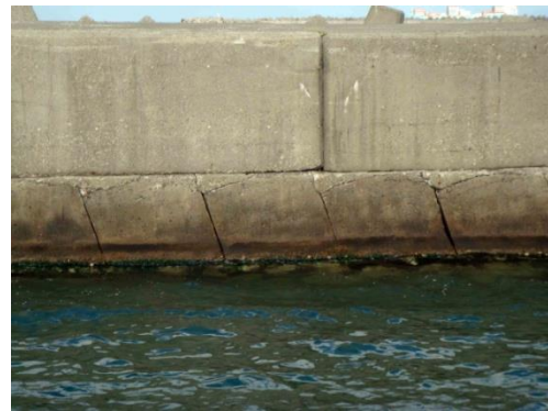
写真-11 北防波堤（下に斜塊ブロック）
