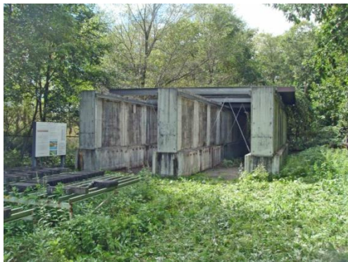
写真-1 保存供試体全景
