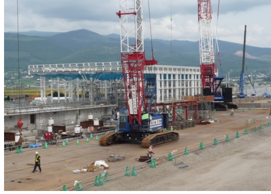
写真2 新函館（仮称）駅建設現場
