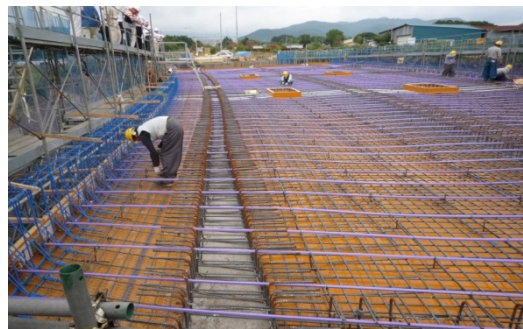
写真8 赤川亀田中野線跨道橋
