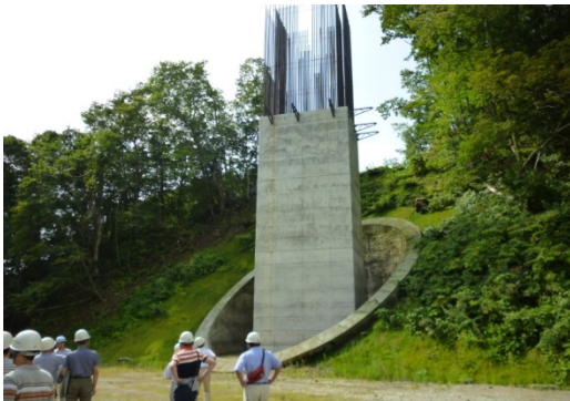
写真5 大釜谷川大橋
