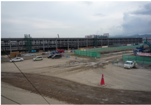
写真3 函館総合車両基地現場
